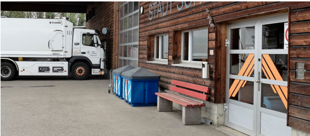
Die Stadt Schlieren will ihren Werkhof mit mehr eigenem Strom versorgen.
