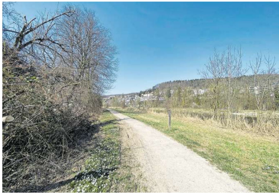
Bald gesperrt: Im Winter konnte der Limmatweg laut Kanton nicht saniert werden. Bild: deg (22. März 2022)
