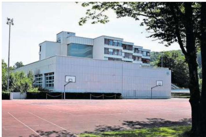
Die vorgesehene Sanierung des Schulhauses Kalktarren wird immer teurer. Bild: Lukas Elser
